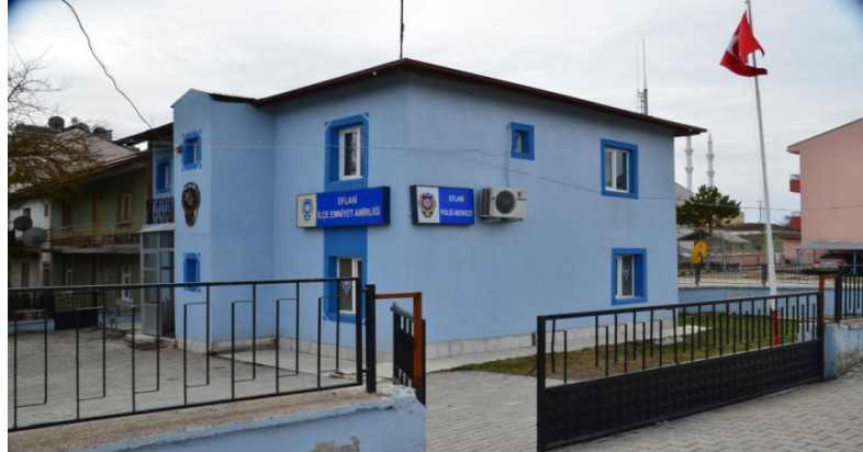
Eski Hizmet Binası
