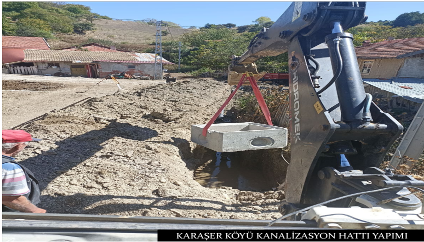
KARAŞER KÖYÜ KANALİZASYON HATTI YAPIMI
