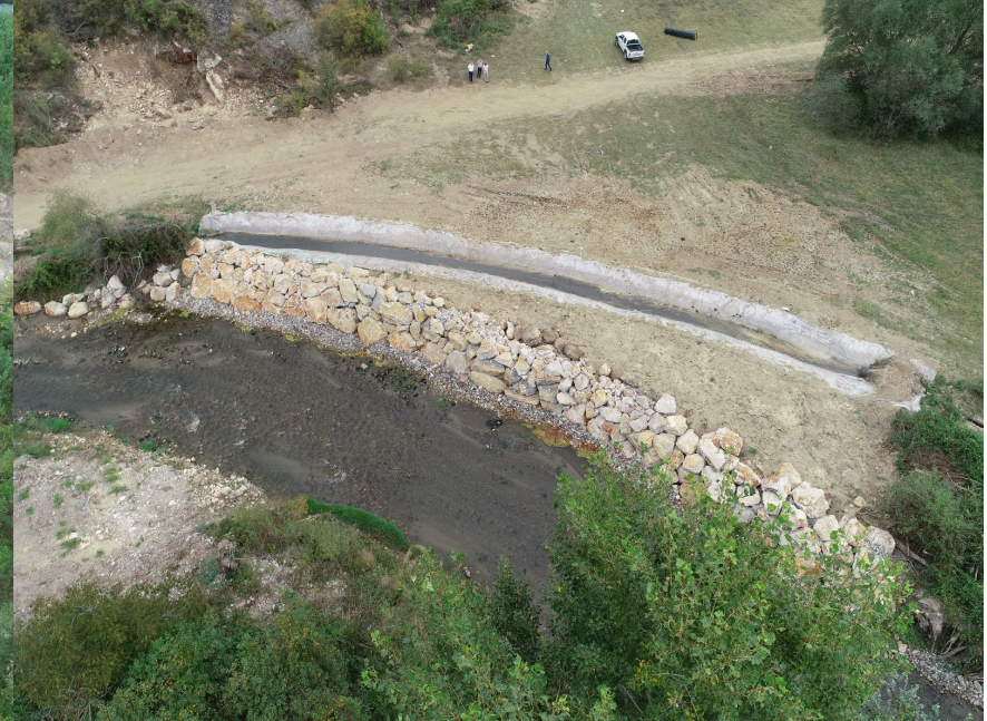
Eskipazar Köyceğiz Köyü S.S.T. Sağ Sahil Taş Tahkimat ve Sulama Arku Onarımı
